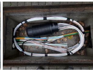
Glasfaserverteilung (Schrank oder Muffe)
