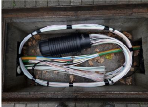
Glasfaserverteilung (Schrank oder Muffe)
