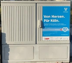
Glasfaserverteilung (Schrank oder Muffe)
