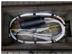
Glasfaserverteilung (Schrank oder Muffe)
