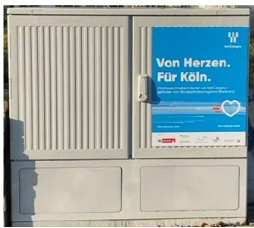
Glasfaserverteilung (Schrank oder Muffe)
